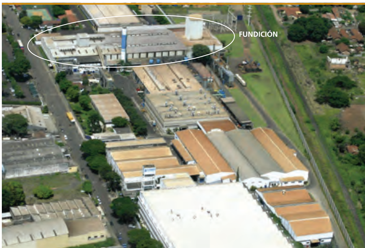
Vista de la Planta 1 donde está la Fundición
