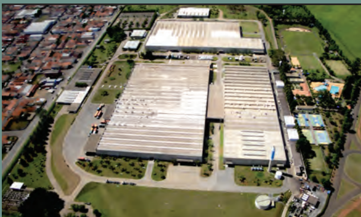
Vista aérea de la Planta 2, la primera que contó con los aforadores Parshall
